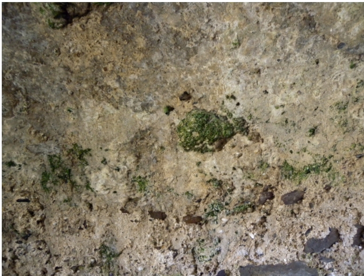
Vue de détail de la voûte intérieure chaulée
