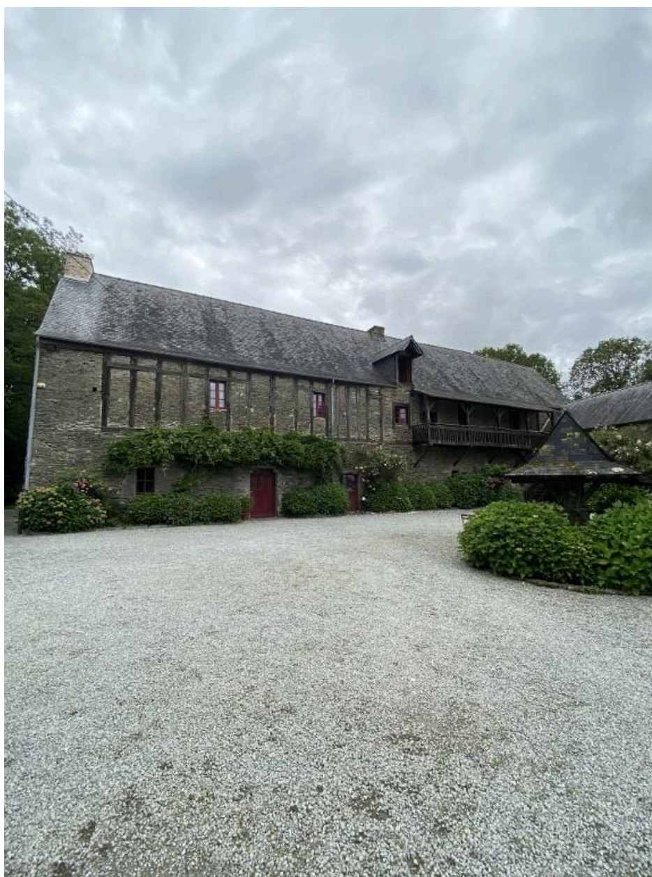
Logis, vue générale nord-ouest
