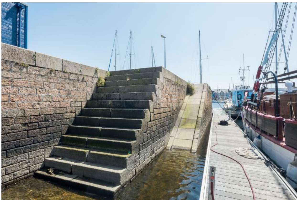
Escalier de la forme de radoub
