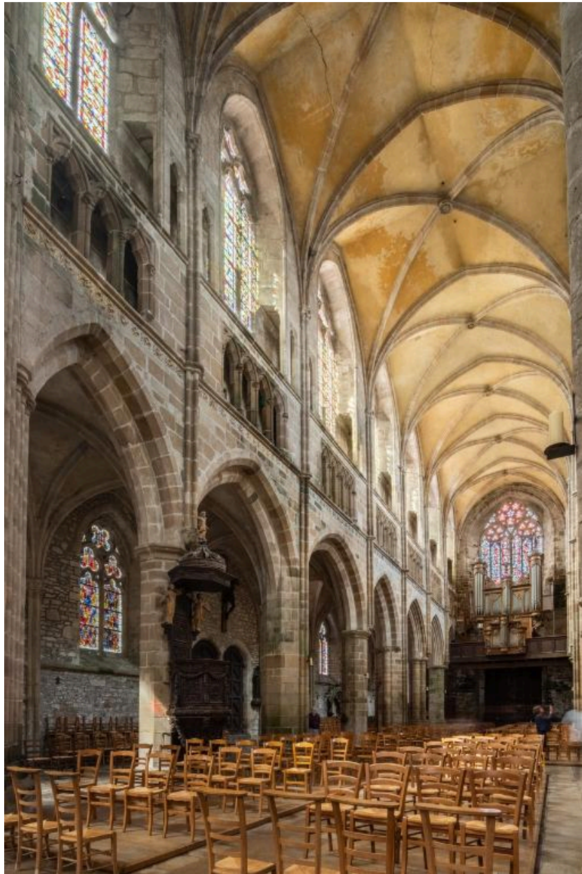
Vue générale de la nef vers l'ouest
