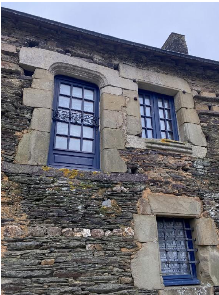
Aile nord, élévation sud, détail
