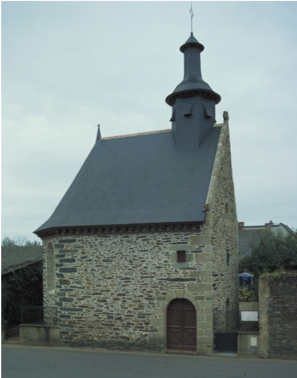
Elévation nord-ouest ; vue générale
