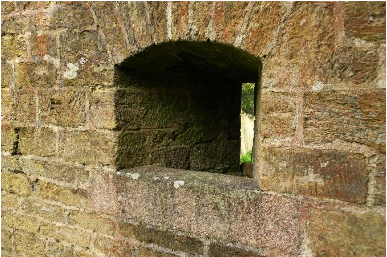
Le Palais, enceinte urbaine, bastion 20, mur crénelé de gauche, détail.
