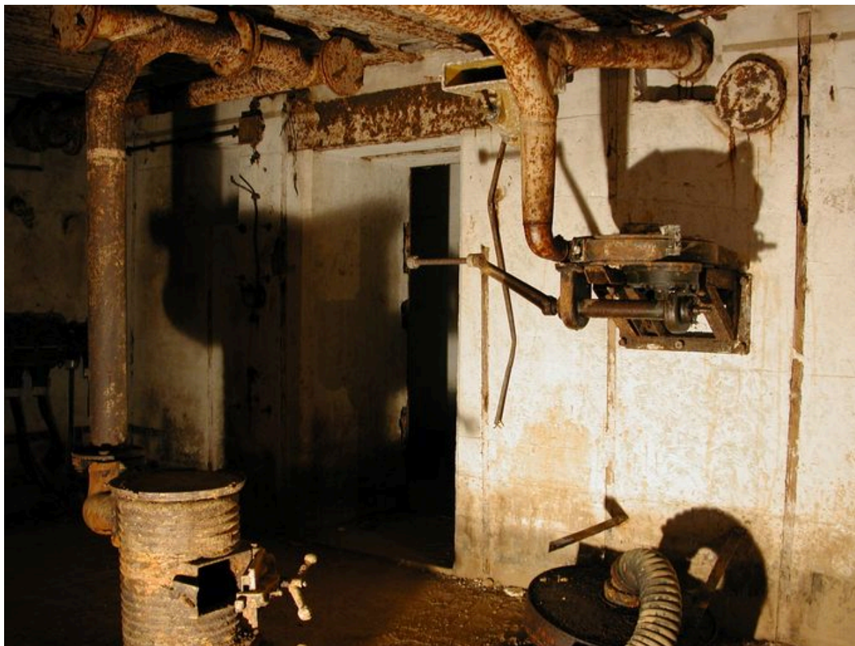
Vue de la chambre de troupe droite : poêle, système de ventilation, filtres de ventilateur...
