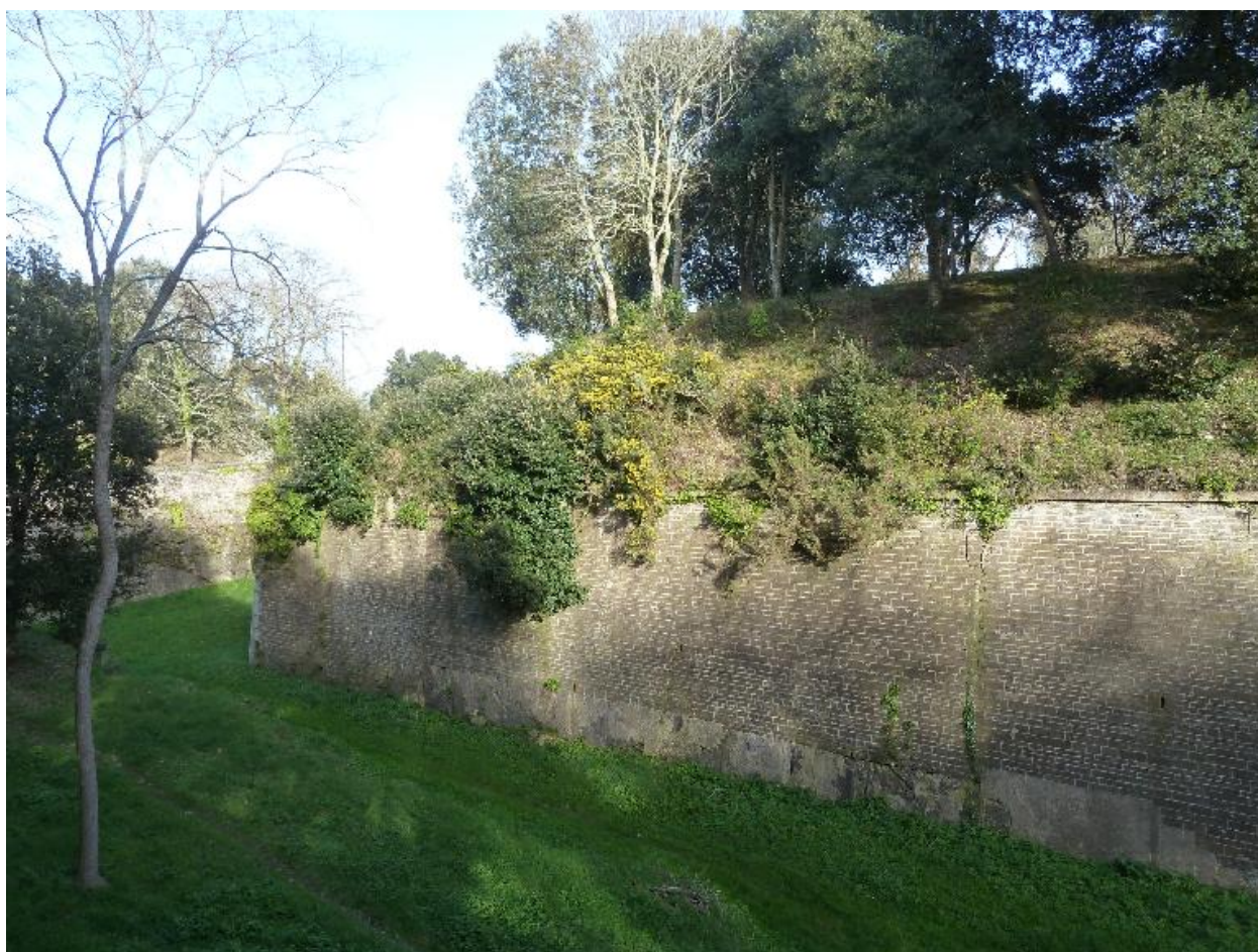
Le Palais, enceinte urbaine, bastion 21, face gauche.
