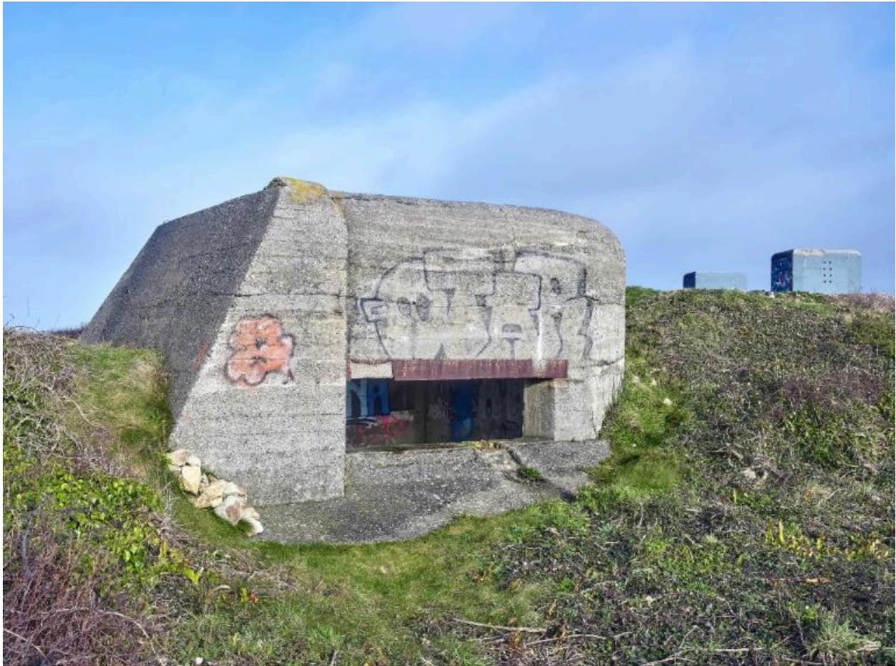
Vue du bunker - casemate, variante d'un type 667 : élévation sud côté embrasure. A gauche, petit mur de flanquement protégeant l'embrasure des coups venant de l'ouest. En arrière-plan, le bunker pour radar Mammout
