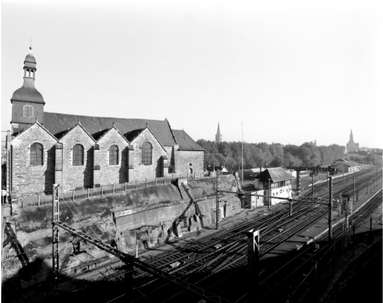
Elévation Sud : vue générale.
