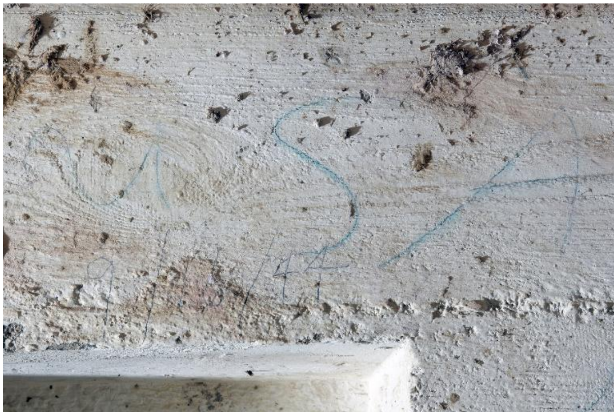
Vue du marquage de l'entrée n° 2 : une date, 16 septembre 1944 et graffitis, photographie réalisée le 11 mai 2009
