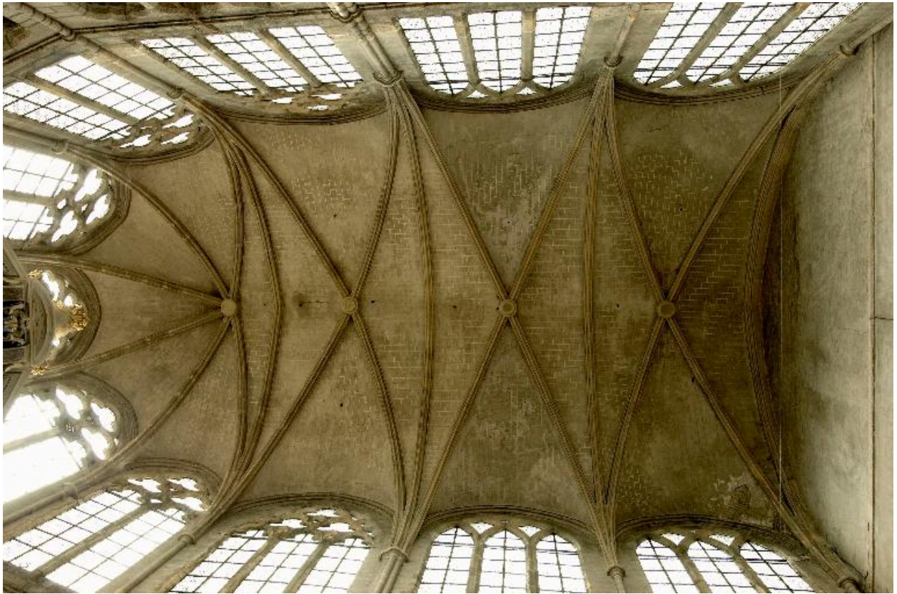
Choeur : vue en contre plongée vers les voûtes
