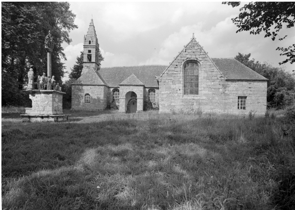
Vue générale de la façade sud
