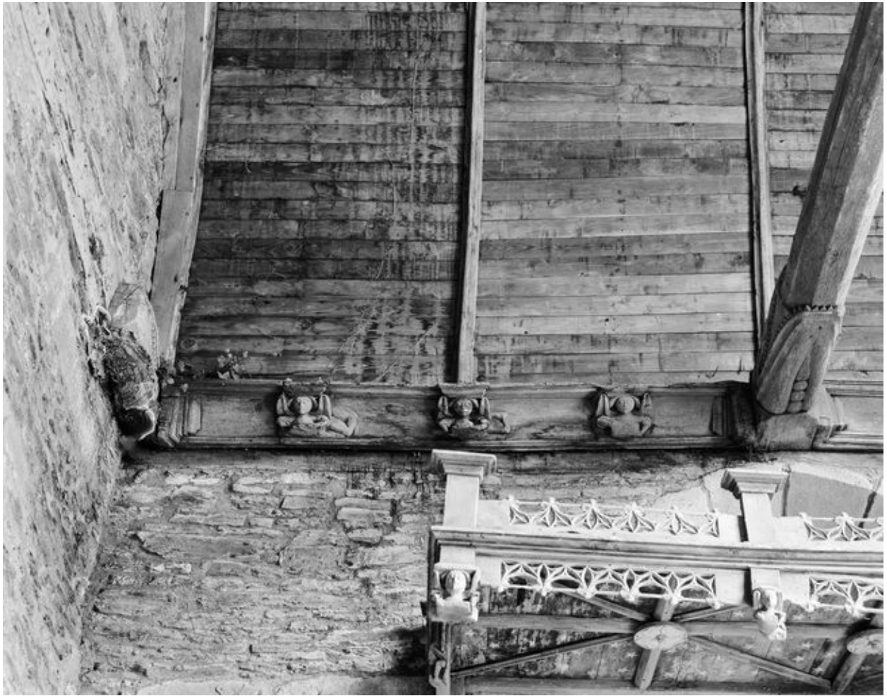
Chapelle, bras sud du transept : sablière côté est (état en 1992)
