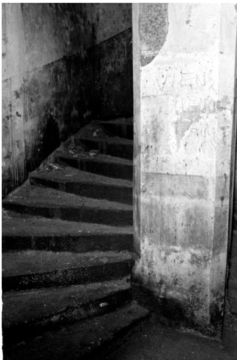
Vue du fort : cage d'escalier (état en 1969)
