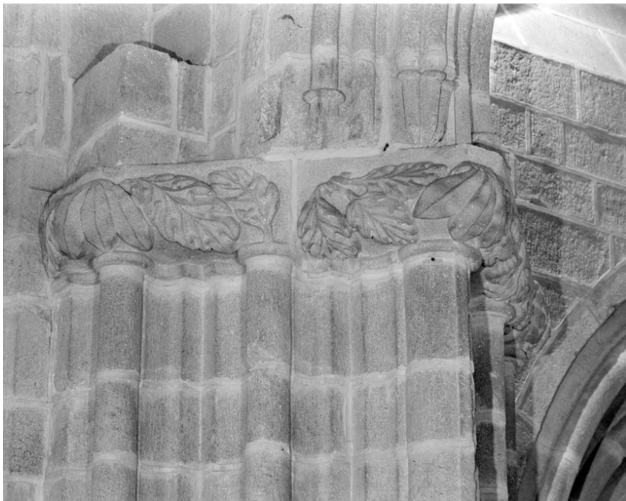
7e pile sud, face sud-est
