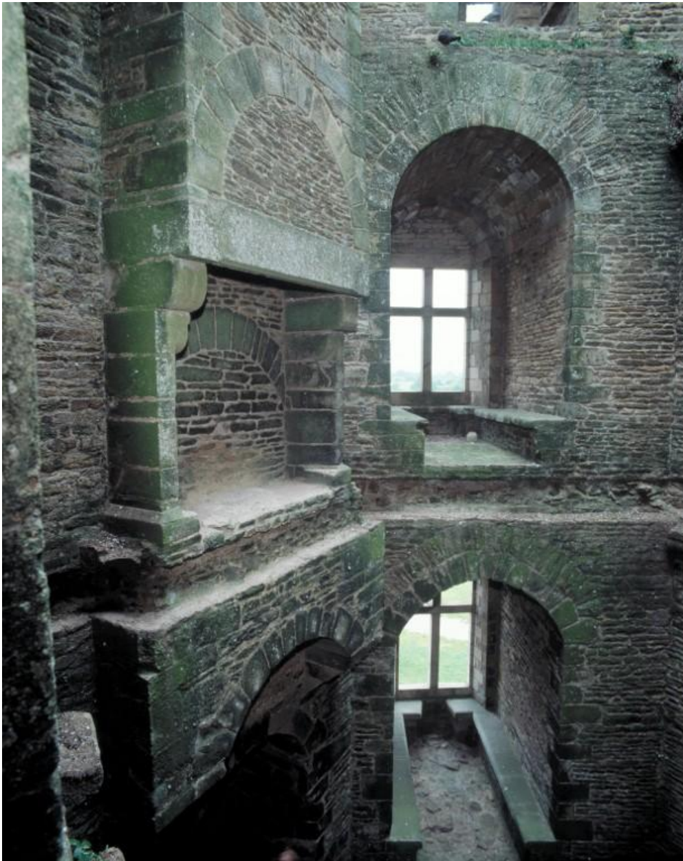
Château fort, logis ouest, tour neuve, quatrième niveau : fenêtres.
