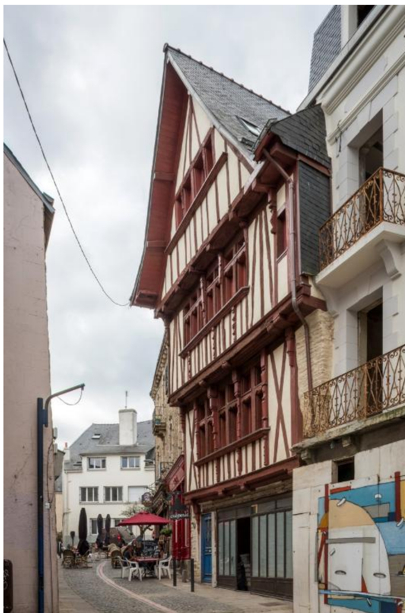
Maison à pignon sur rue et encorbellement sur solives avec entretoises (8 rue Savary)
