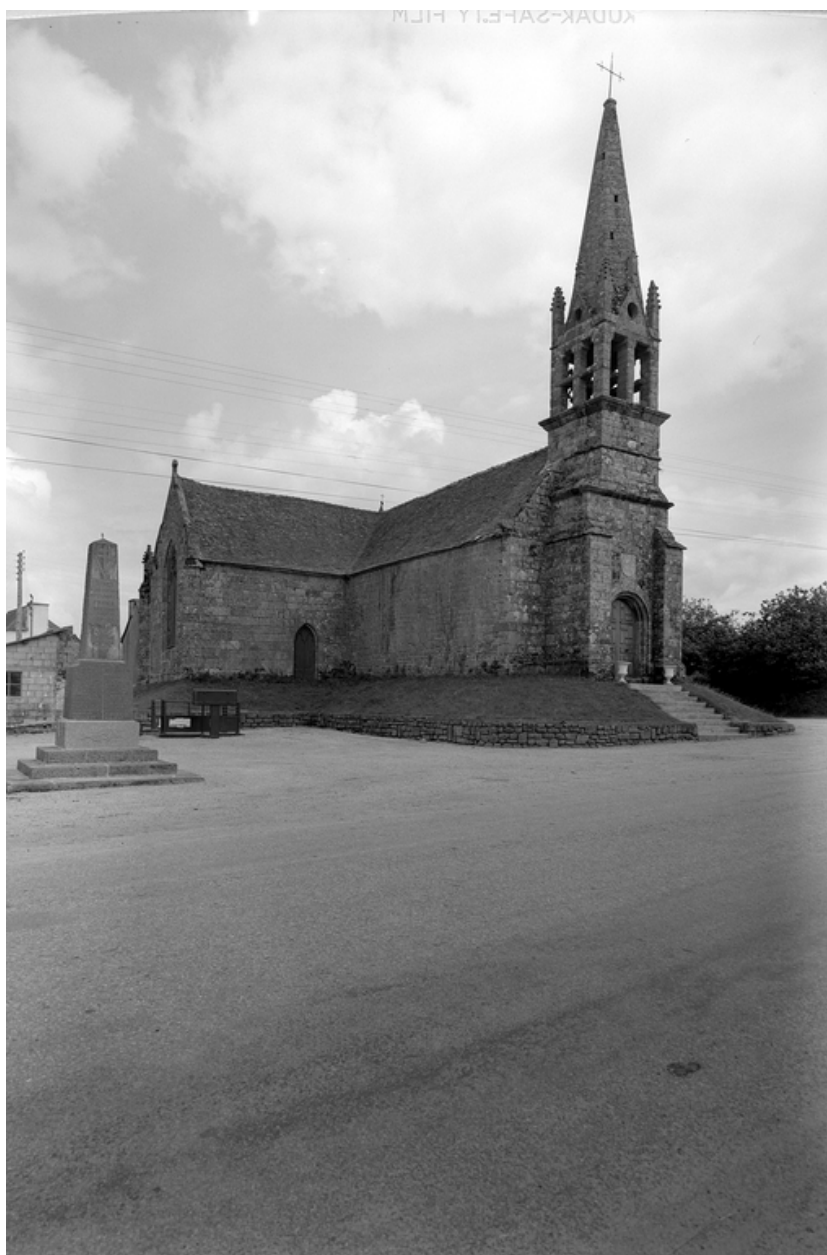
Vue de situation prise du nord ouest
