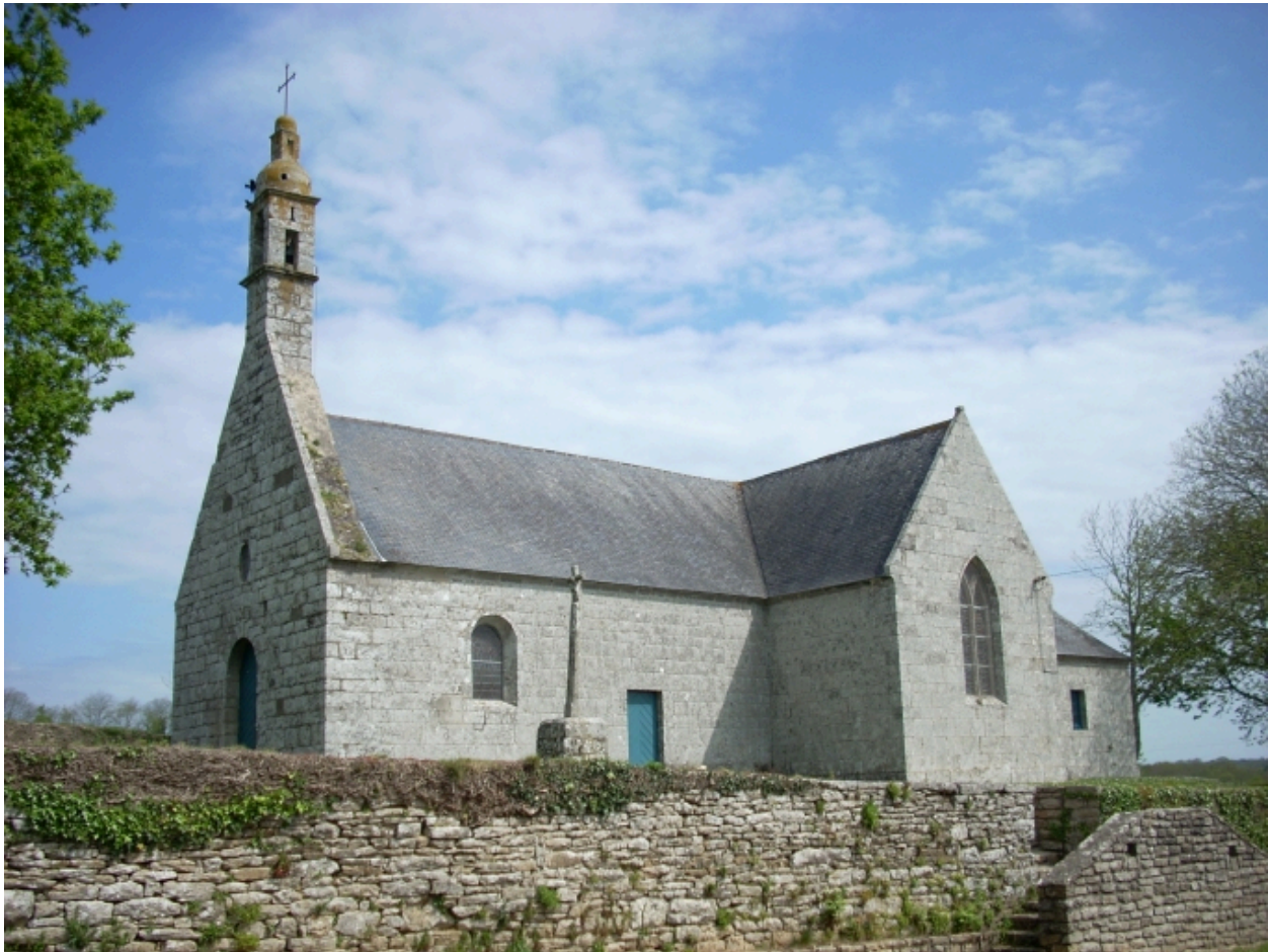
Pluguffan, chapelle Notre-Dame-des-Grâces : vue générale sud-ouest
