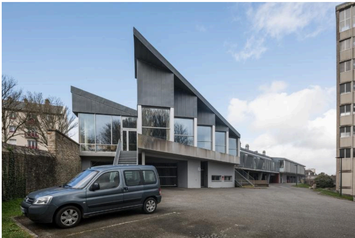
Bâtiment E, restauration, angle ouest. Michel Grignou, Gwénolé Chateau, architectes, 2002.
