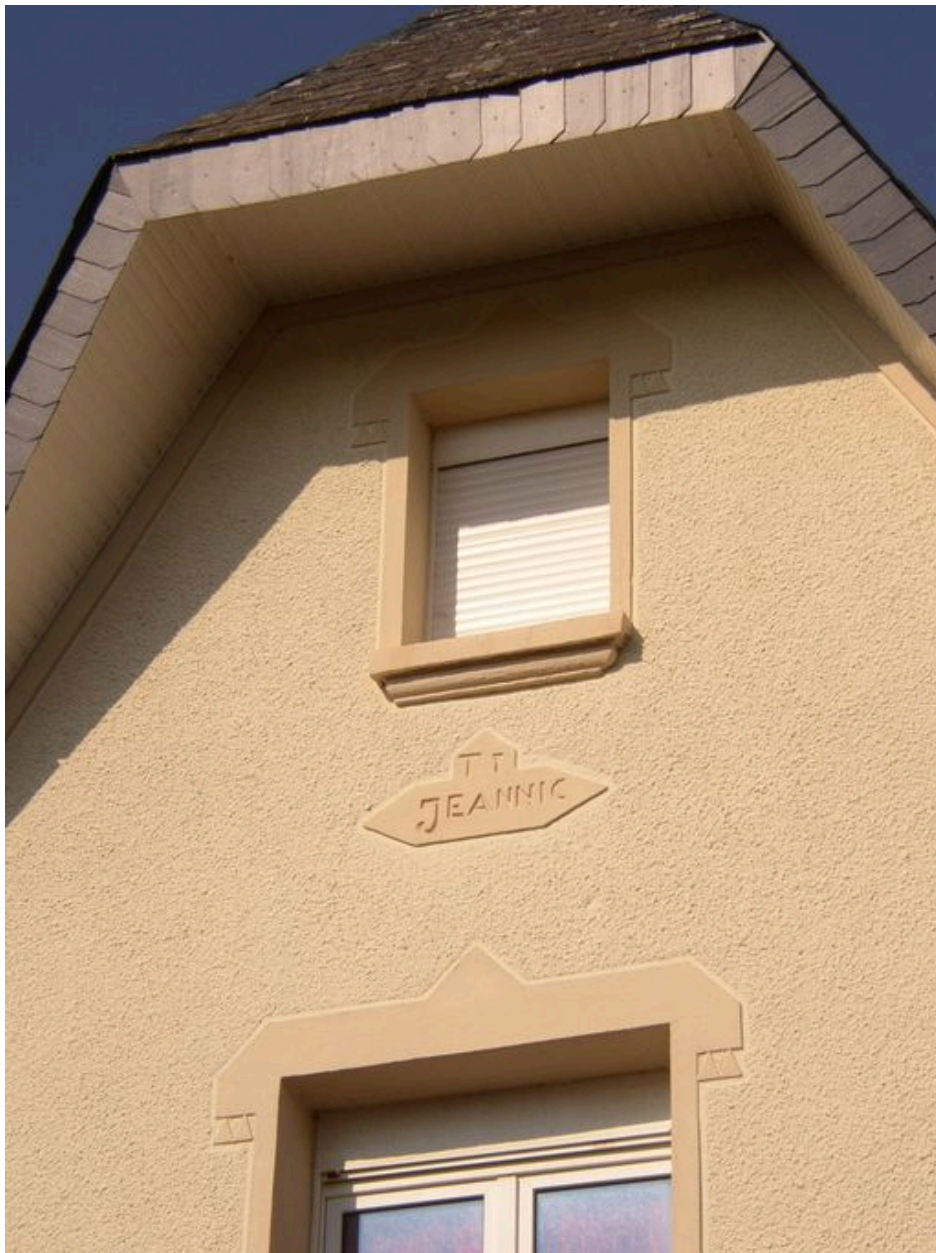
Détail du pignon coupé de la villa Ty Jeannic mentionnant le nom de la villa
