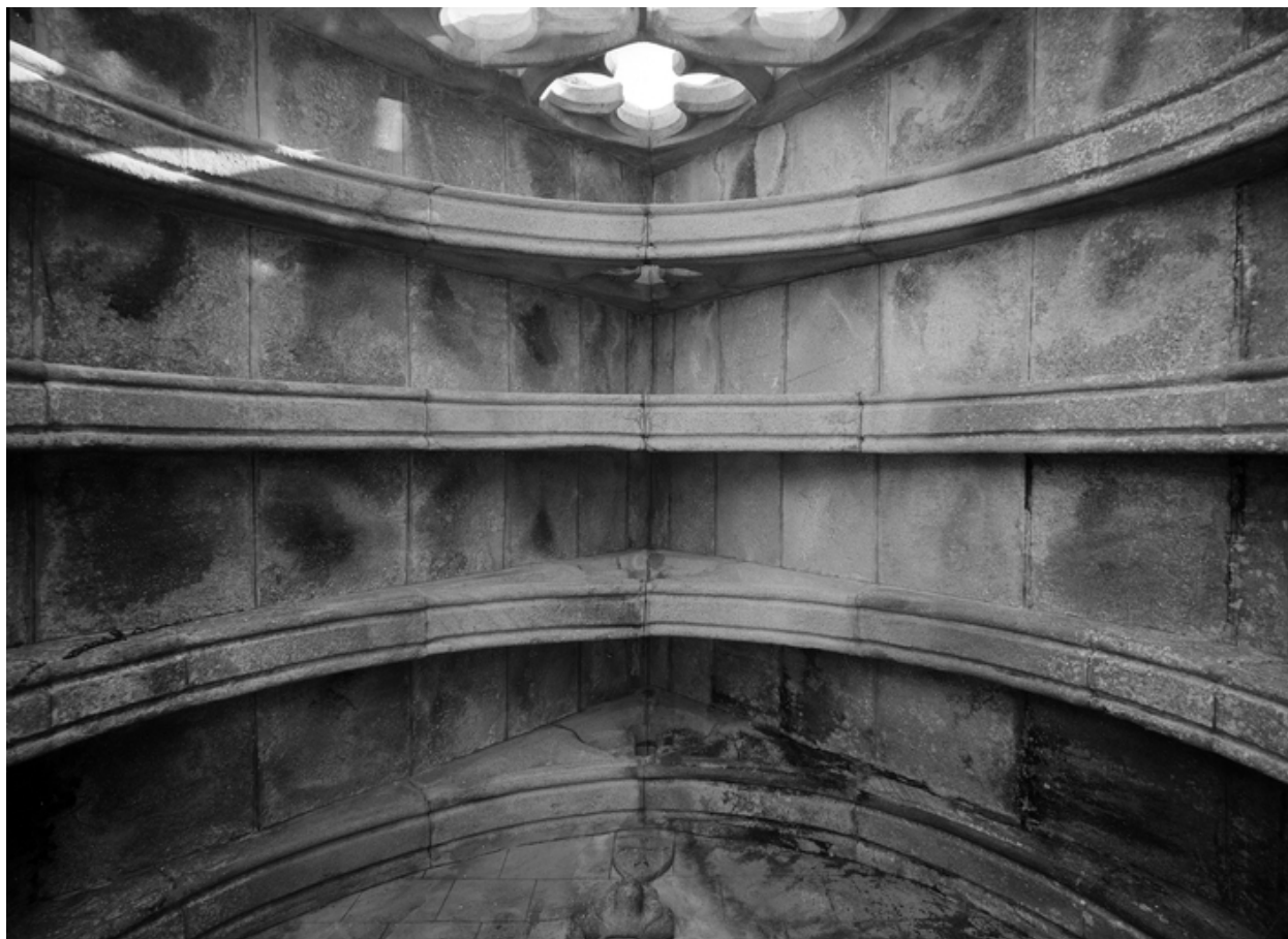
Plafond du porche sud
