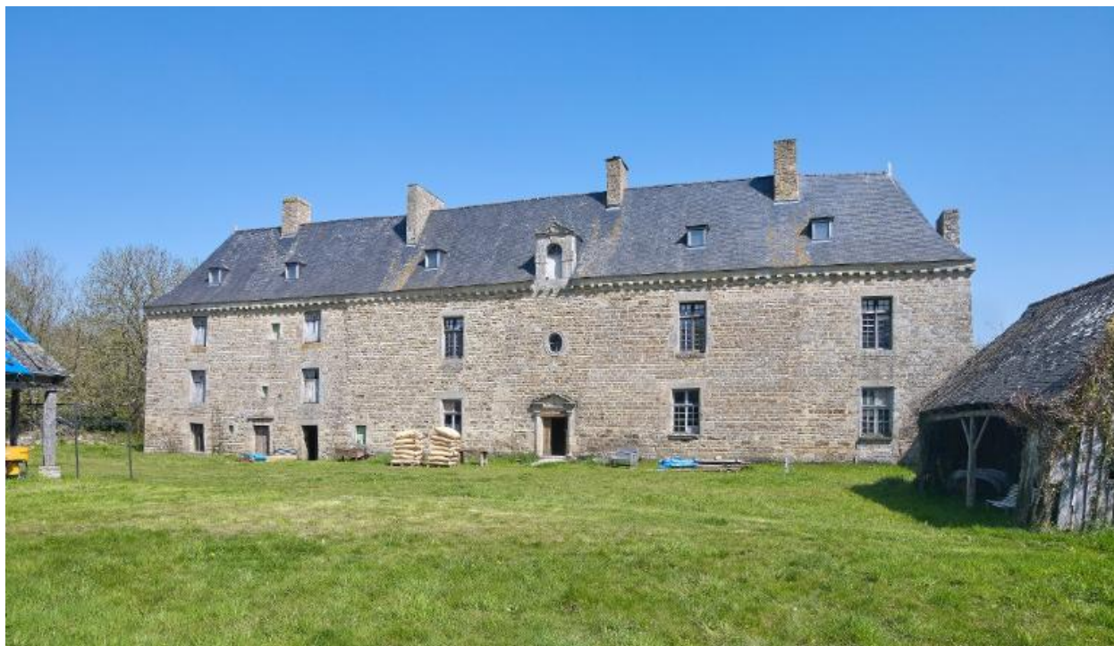
Façade ouest du manoir
