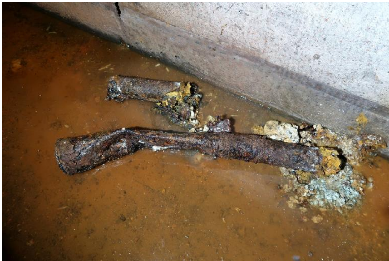
Vue intérieure : gargouilles baignant dans l'eau
