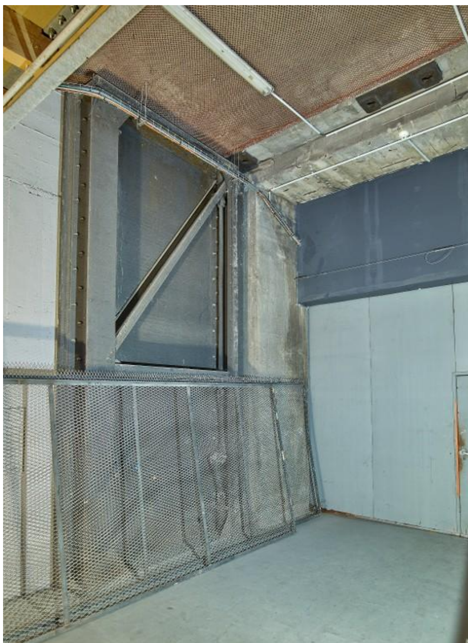
Vue de l'extension sud : porte blindée. Cette porte débouche dans le hangar H1
