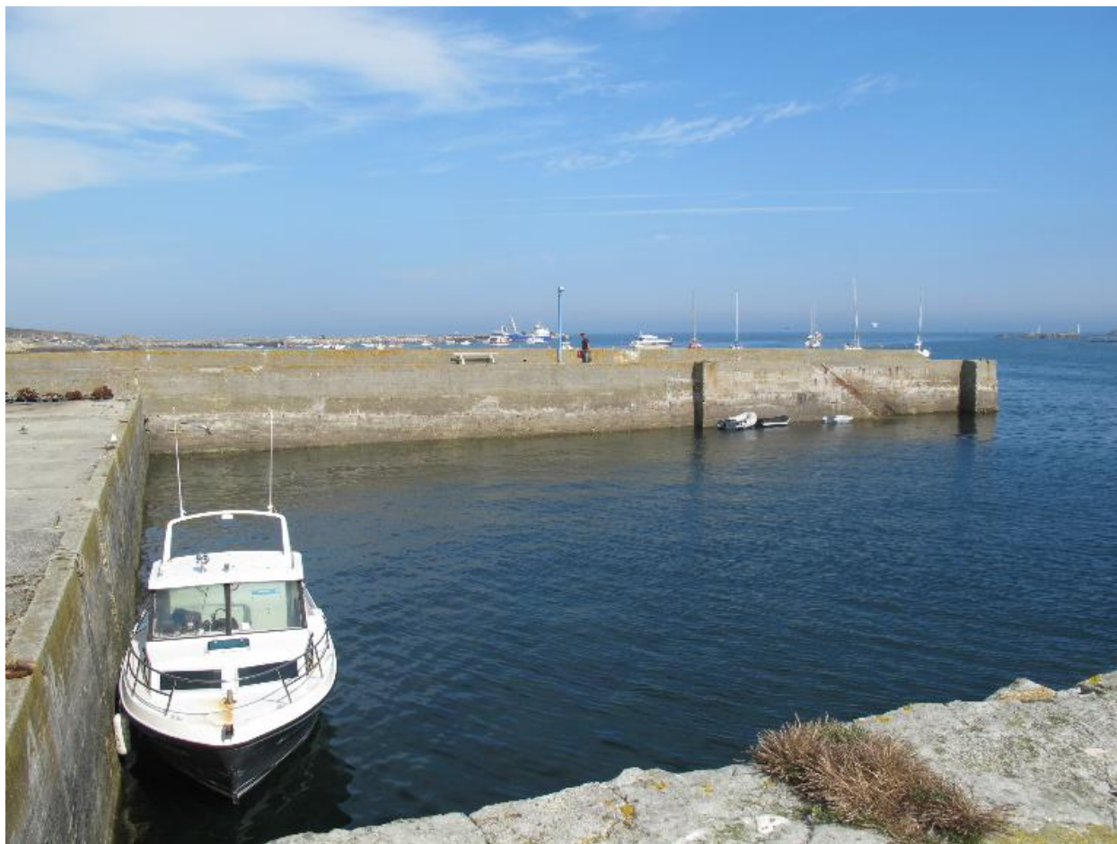
Le port de Molène, digue et terre-plein (1963)
