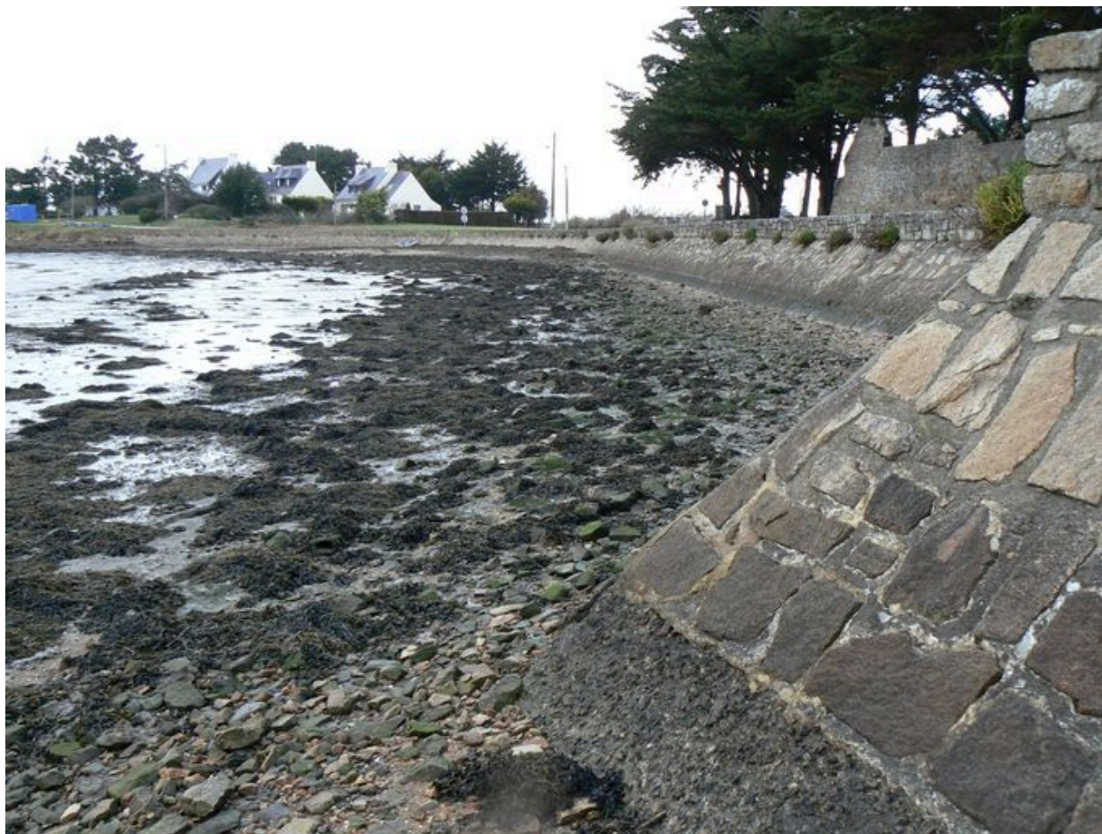
Digue de la Garenne
