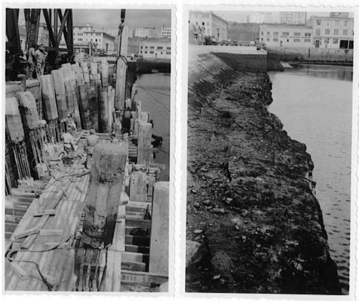
Photographies de suivi de chantier : perré provisoire (1945) et arase du quai de 1860 ;
