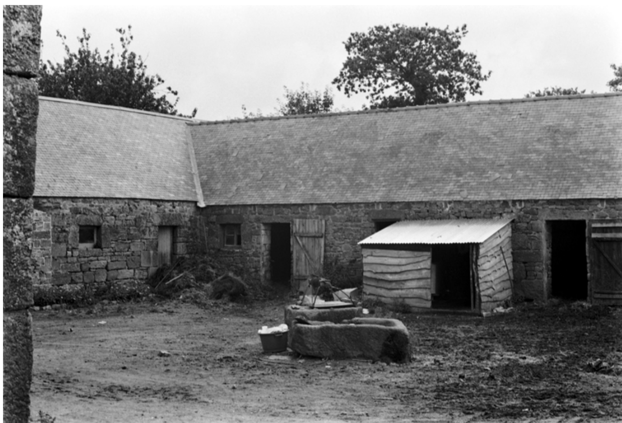
Communs au sud de la cour
