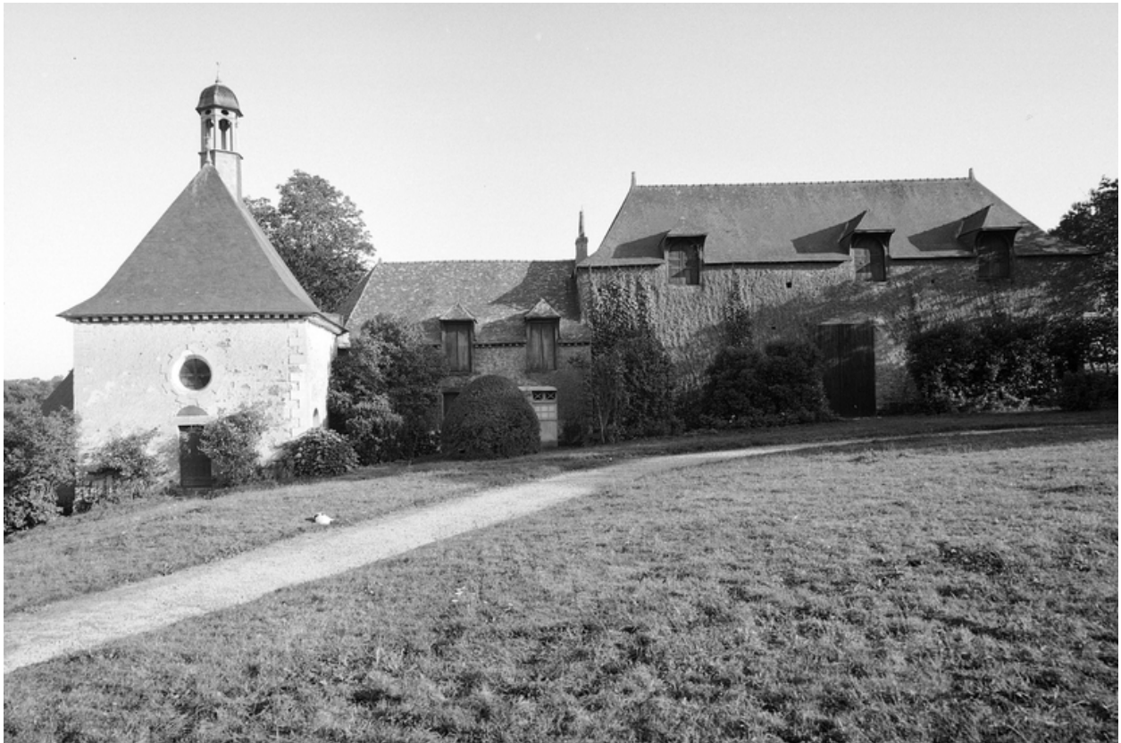
Cour intérieure, aile sud.
