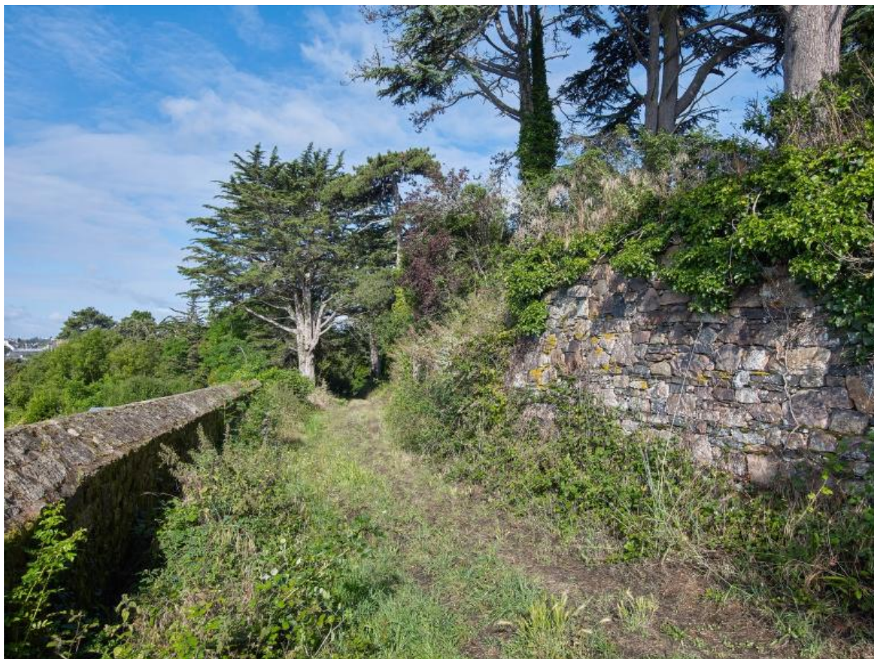
Vue du mur de clôture au Sud. A droite, mur de soutènement du jardin d'agrément
