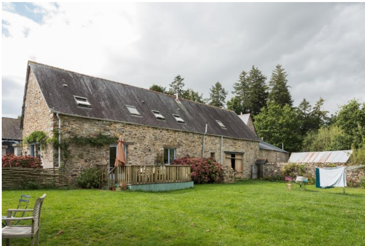
Etable, élévation nord-est, vue générale
