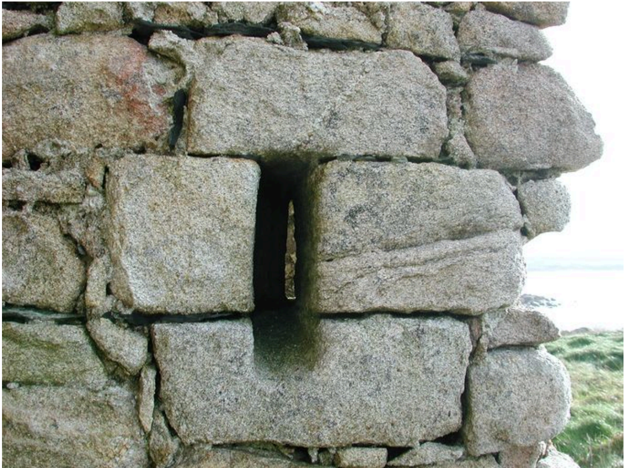
Santec, Ile de Sieck : vue d'une des deux ouies d'aération en chicane de la petite poudrière adossée au pignon du corps de garde
