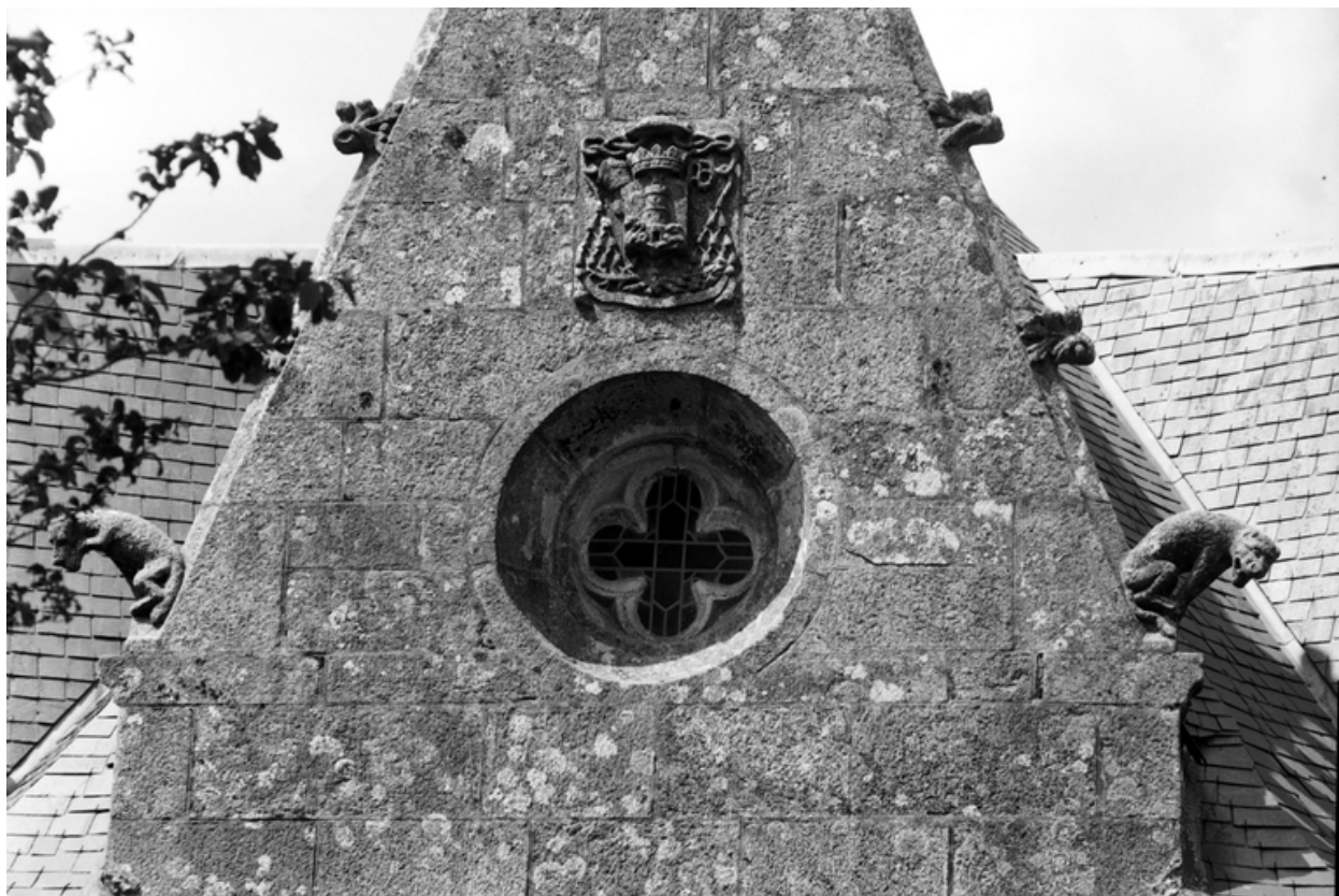
Mur est du chevet : détail de l'écu et des pierres d'assise du rampant
