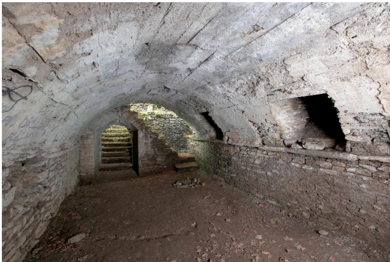
Vue intérieure de la cave
