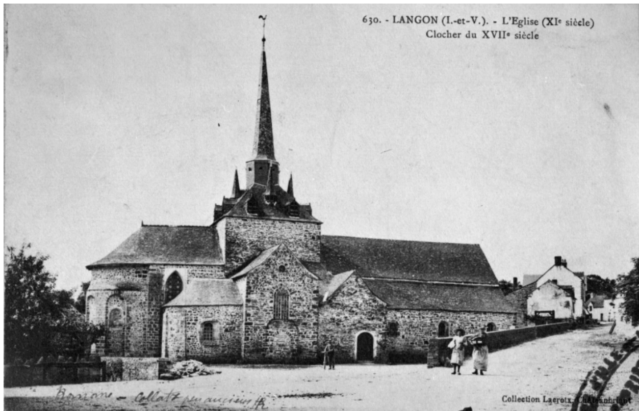
Elévation nord : vue générale (carte postale ancienne)
