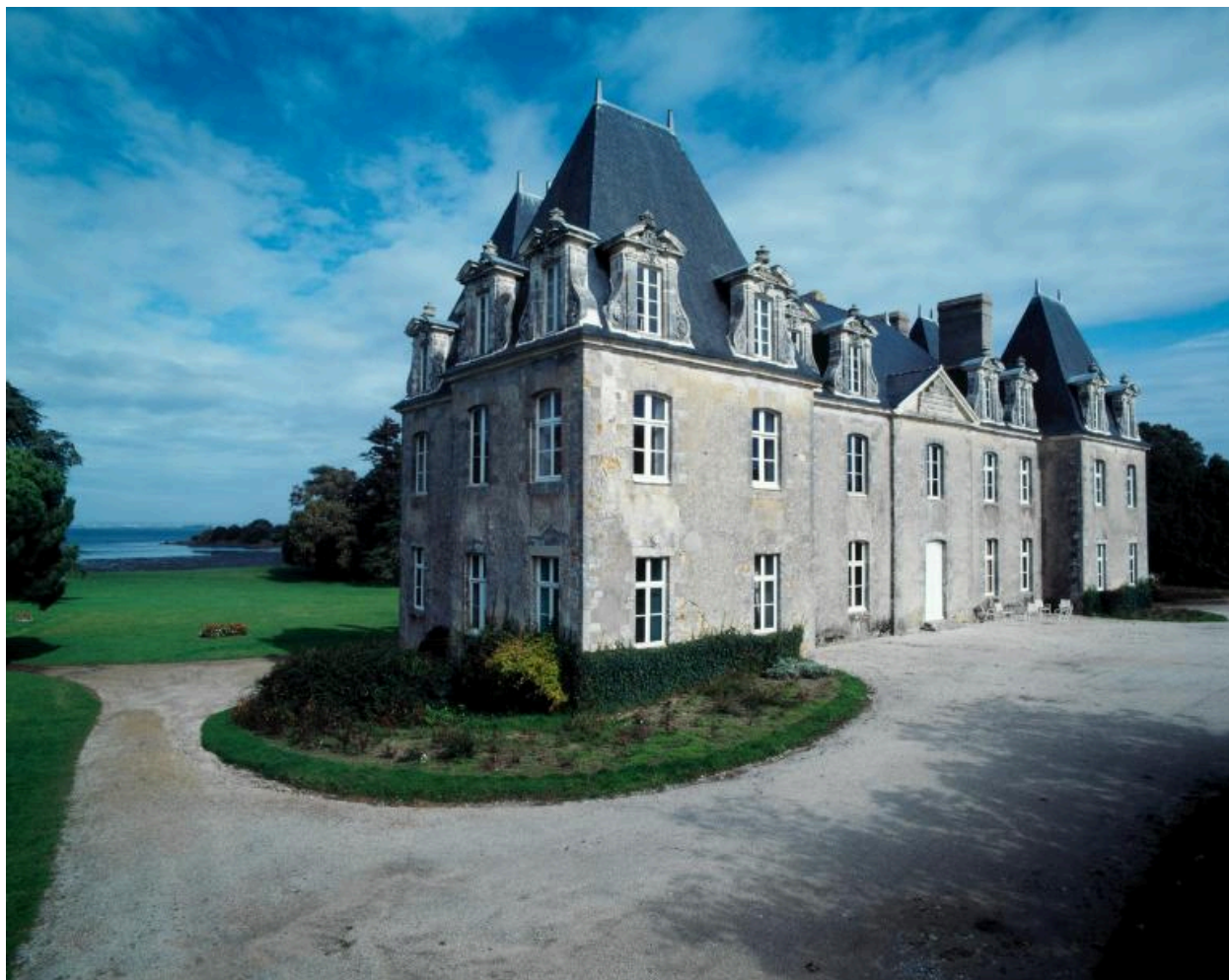
Château, vue générale sud-ouest.
