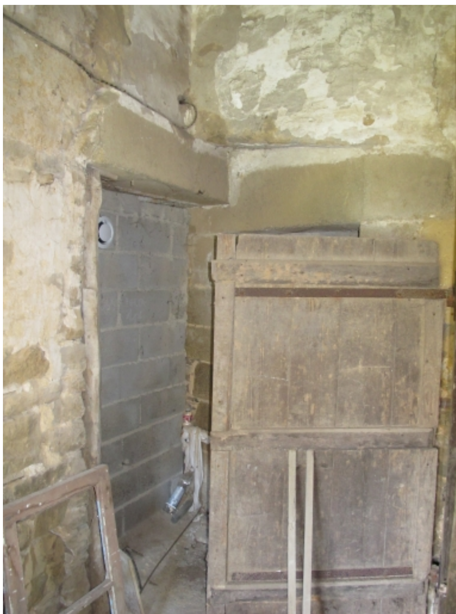
Vestibule situé en partie nord du logis
