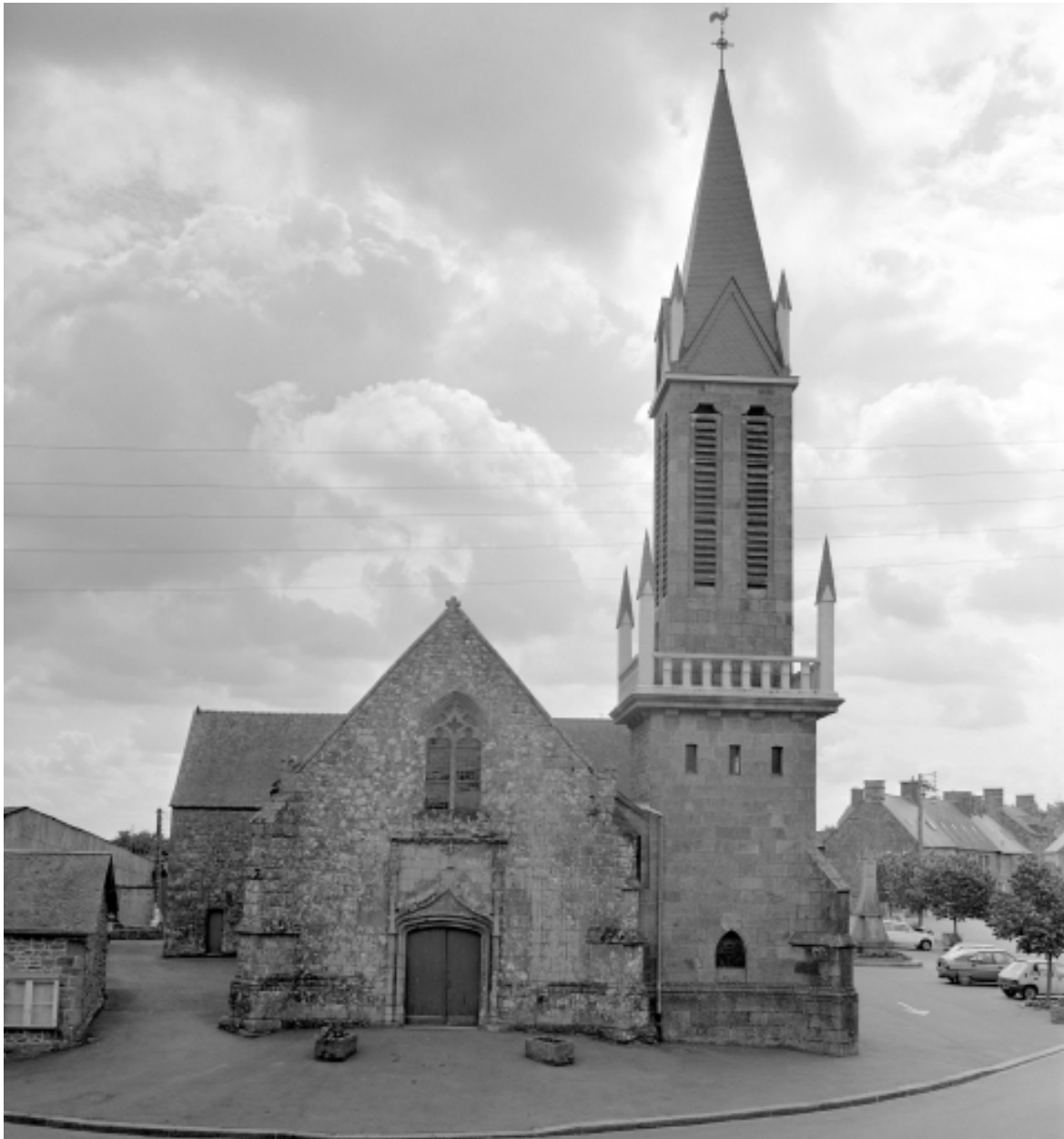
Elévation Ouest : vue générale
