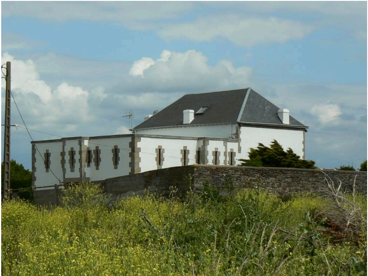
Vue générale du fort du Pouldu
