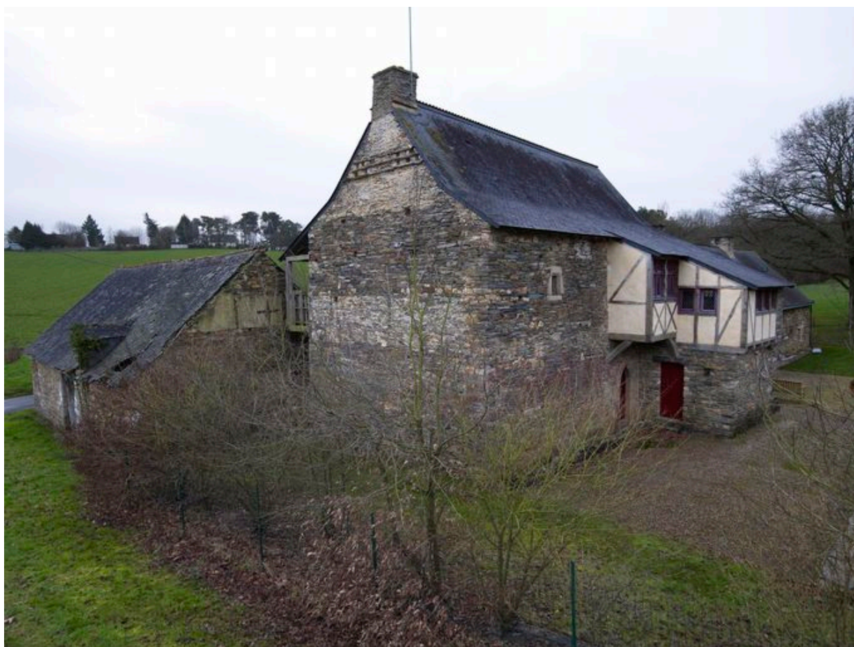
Manoir : vue générale prise du nord-est (état en 2012)
