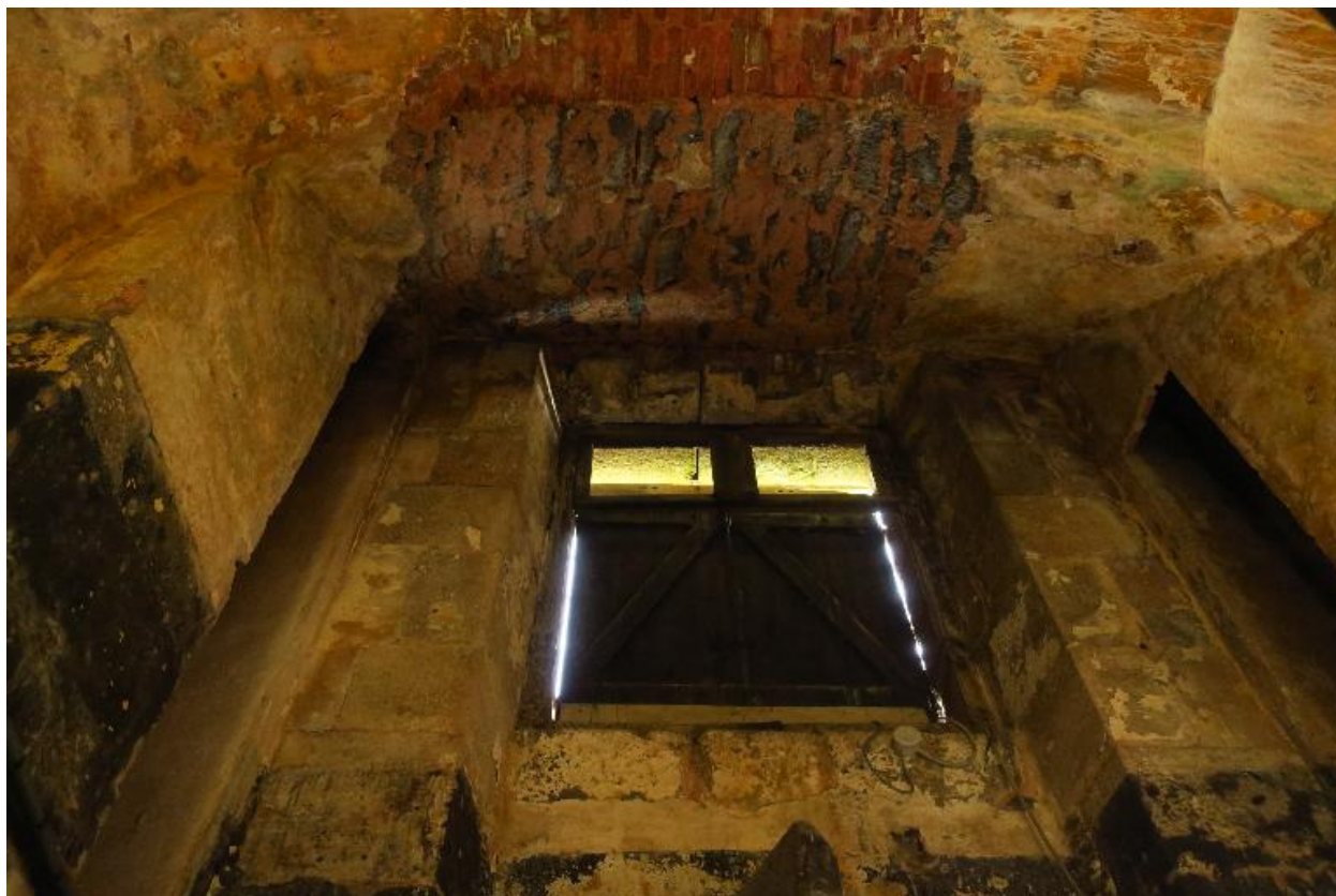
Le Palais, enceinte urbaine, réduit A, travée centrale, détail de la voûte côté ville.
