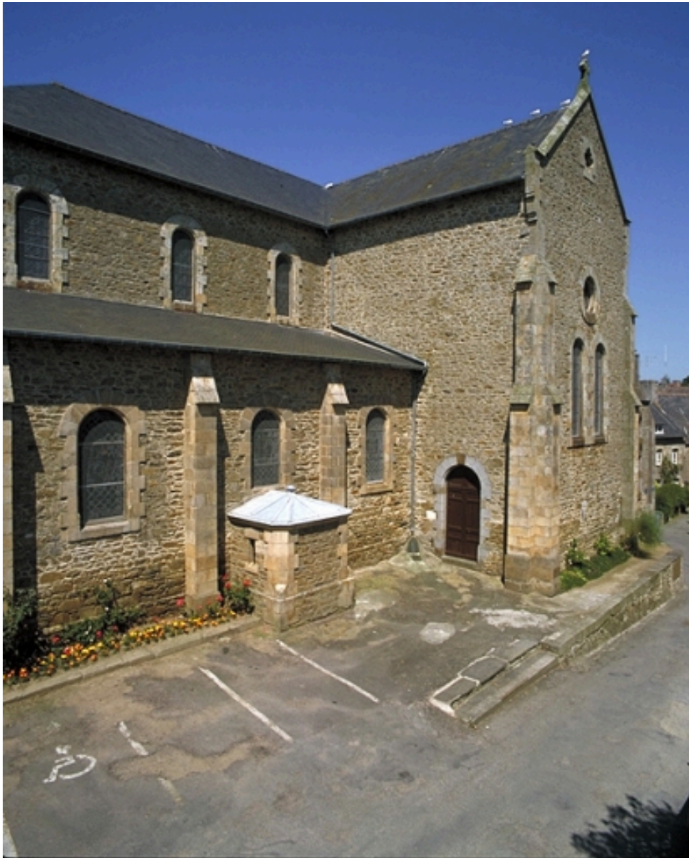
Vue générale sud
