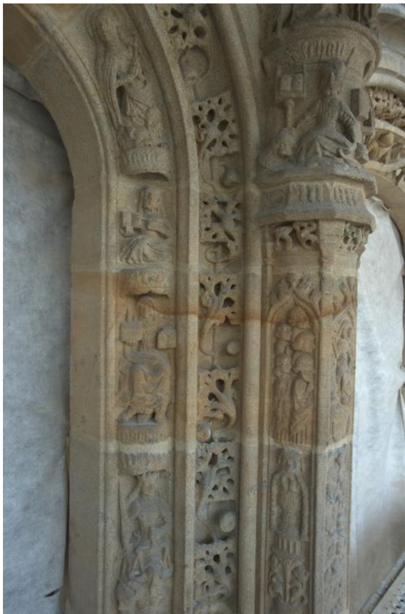
Portail nord, trumeau entre les deux fenêtres
