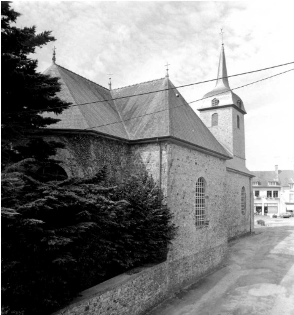
Elévation nord : vue générale
