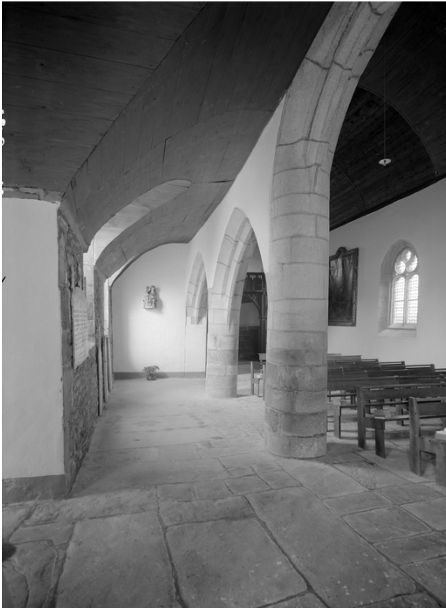
Bas-côté sud d'est en ouest
