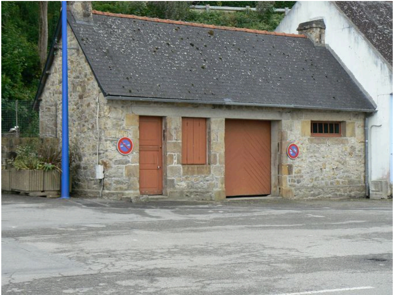
Vue générale du magasin des Ponts et Chaussées
