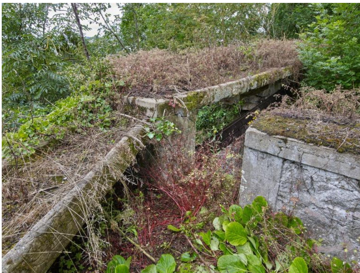
Vue de la serre située au Sud : rez-de-chaussée, bacs de culture en faux bois en ciment armé
